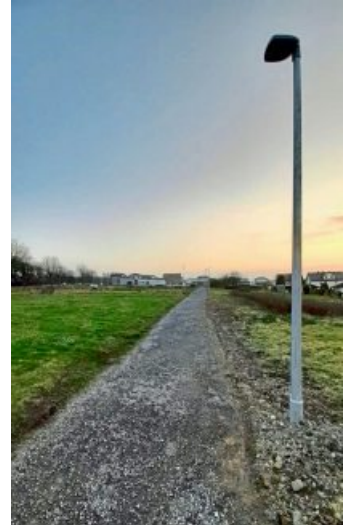
Vom größten Baugebiet in Bad Wünnenberg gibt es jetzt einen sicheren und beleuchteten Schulweg für die Kinder der Grundschule.
